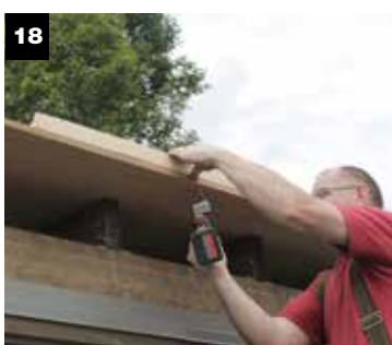
Skrus på trekantleker på 3 sider av tak
