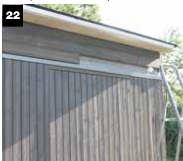
Skrus på dekkbord front samt hjørnebeslag
