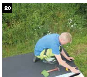
Rull på selvklebende takpapp. Lim skjøter
