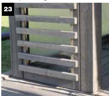
Skrus på sprosseskassett på glass-element
