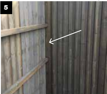
Tilpasningsføring i skjøt mellom skillevegg og yttervegg
