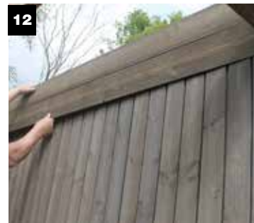
Over skillevegg: Plasser og skrus fast toppelementet
