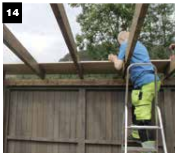
Legg på plass alle takplater/undertak
